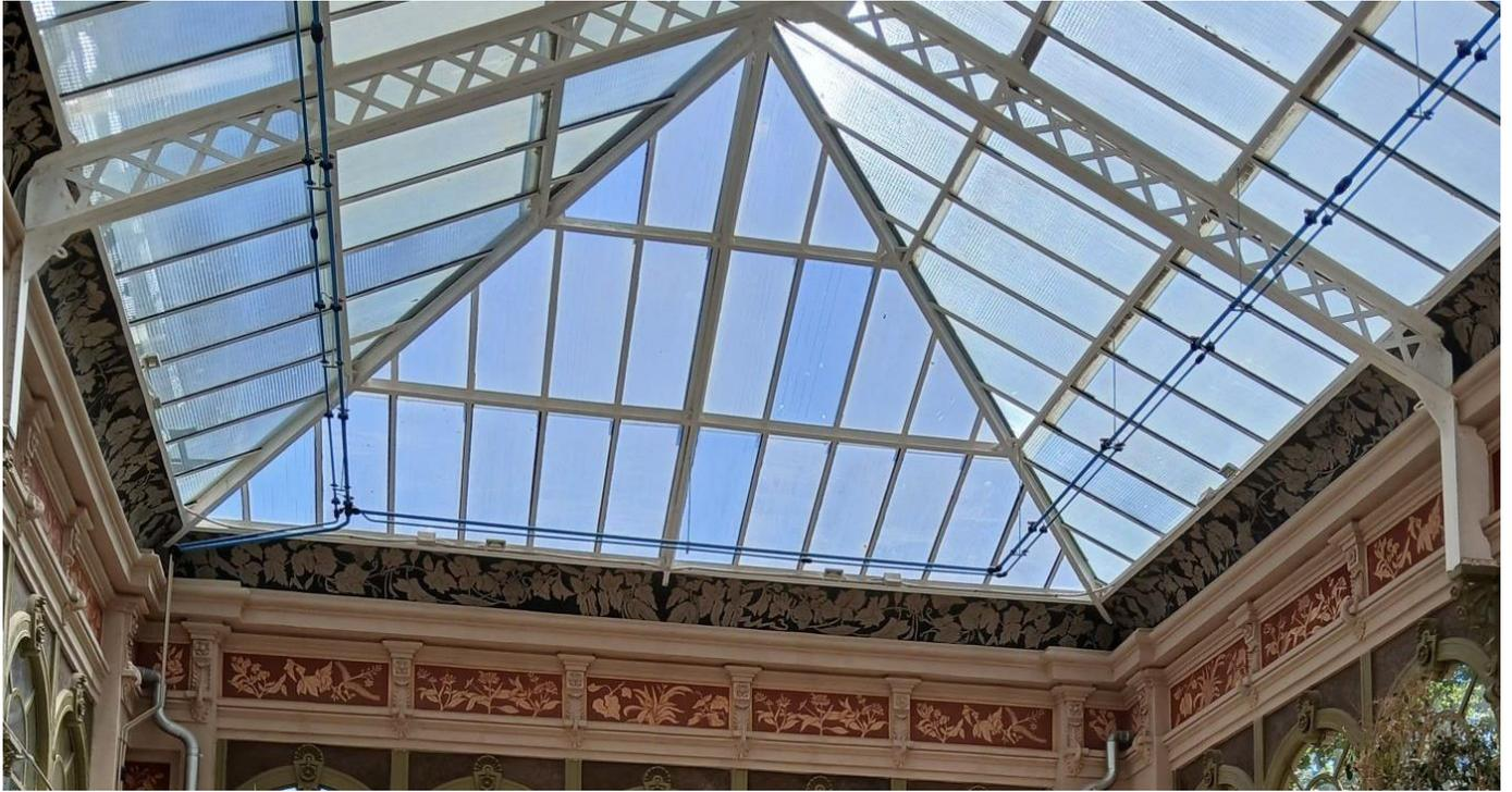
Durante el proceso de rehabilitación, se ha instalado un sistema de motorización de las ventanas y claraboyas que permite controlar la temperatura en el interior del edificio a través de sensores programados.
